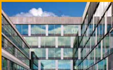
Kleben und Dichten im Fassadenbereich
