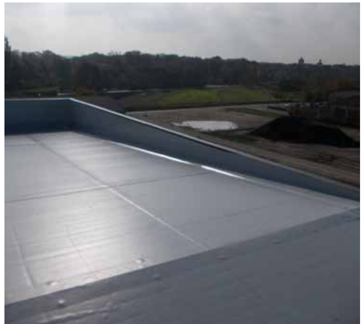
Bild 6: Das Satteldach verläuft hinter der Fassade
