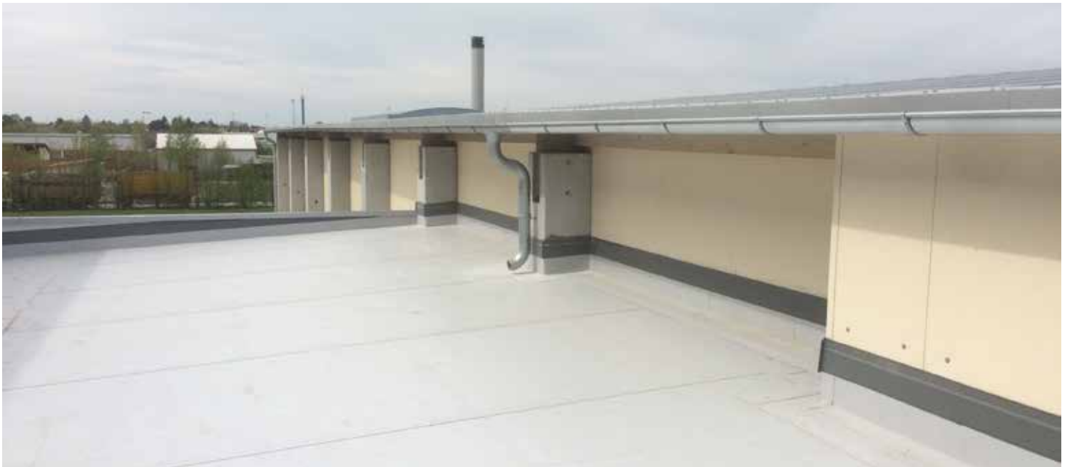
Bild 4: Professionell verklebte Dichtungsbahnen gewährleisten absolute Wasserundurchlässigkeit
