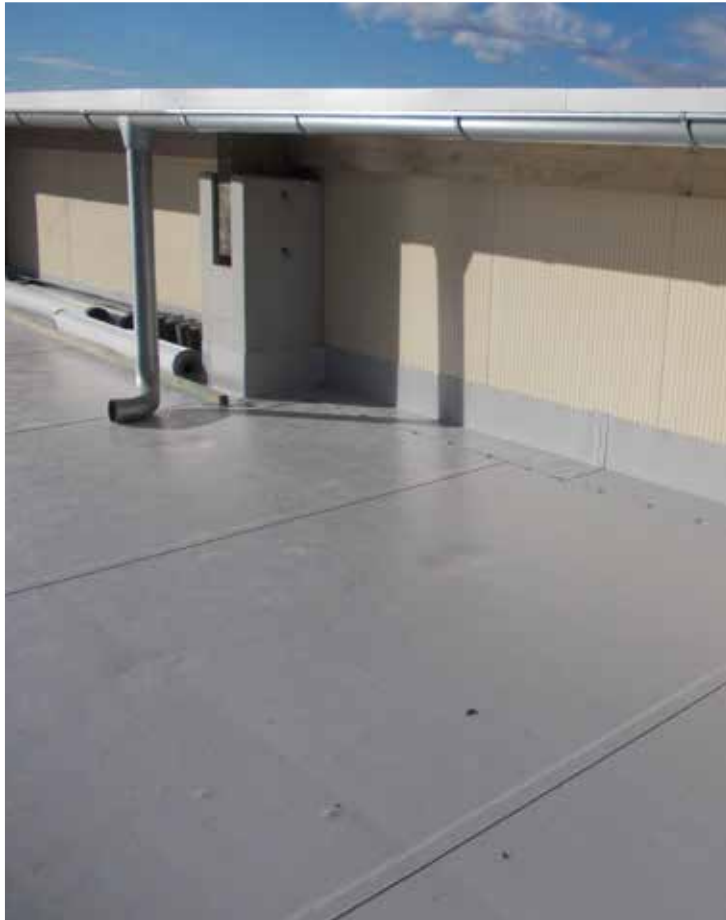
Bild 2: Wandanschluss aus Folienverbundbelch inkl. Schälsicherung
