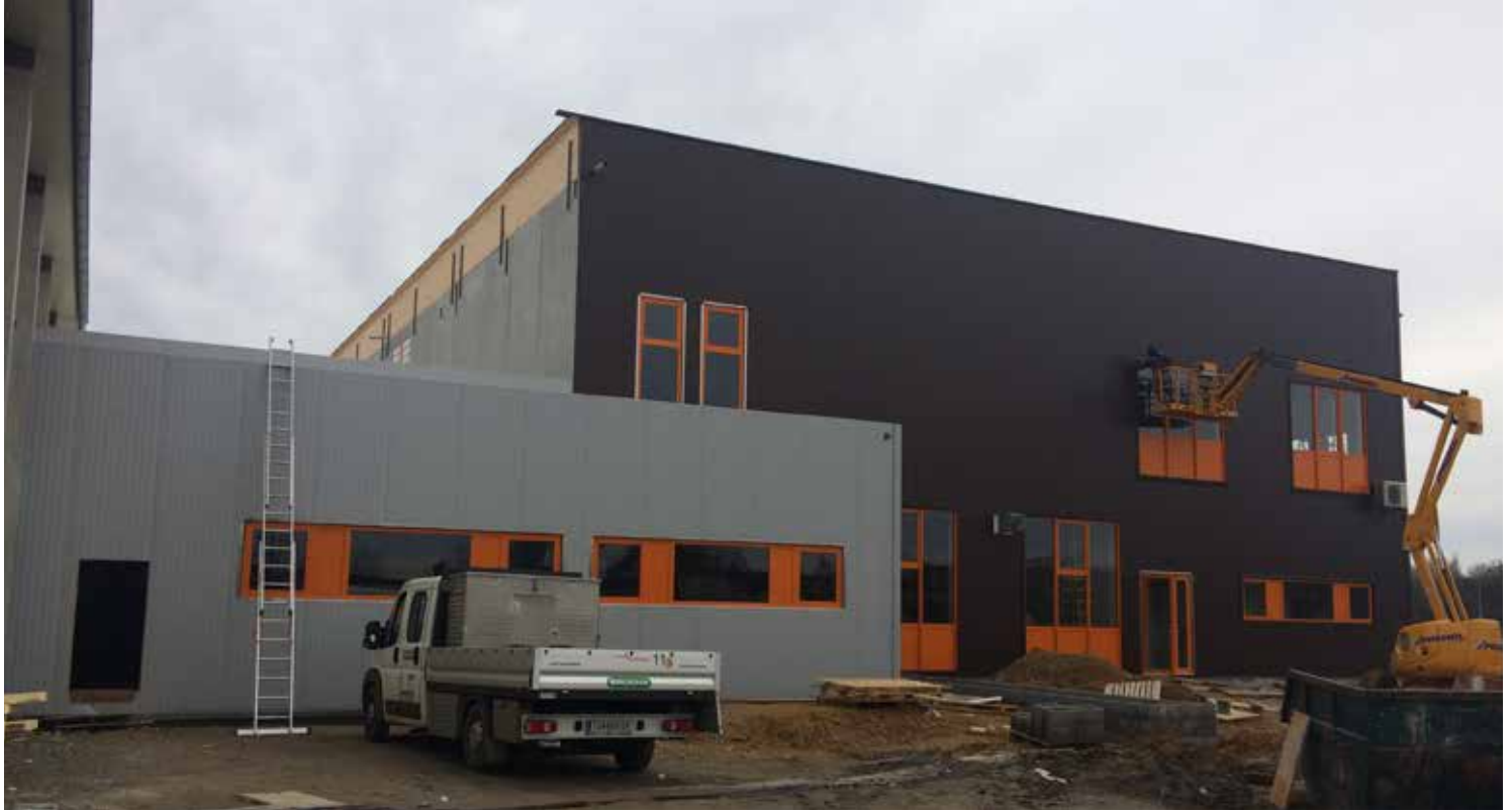
Bild 1: Das vertikal verlegte BRUCHAPaneel® PU Wand - WP muss fachgerecht abgedichtet werden
