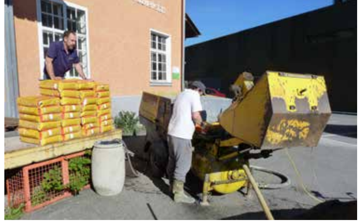
Bild 7: Anmischen des Zementestrichs mit SikaScreed® P-24
