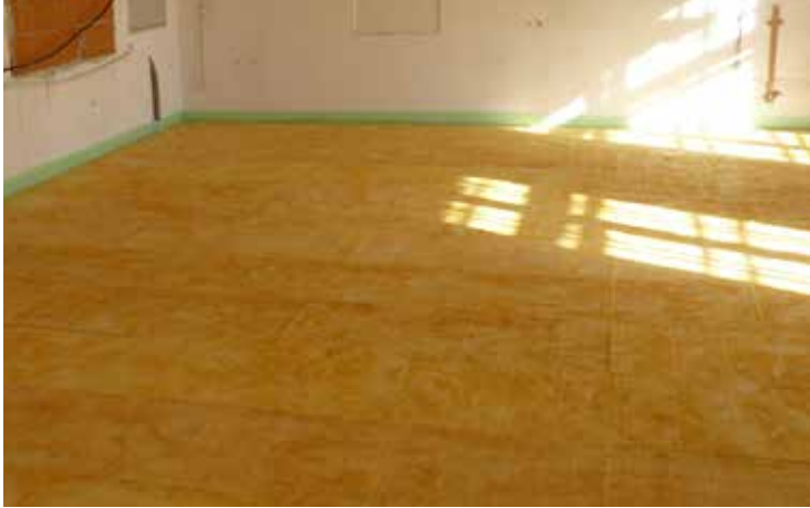
Bild 6: Tritttschall- und Wärmedämmplatten für die optimale Nutzung
