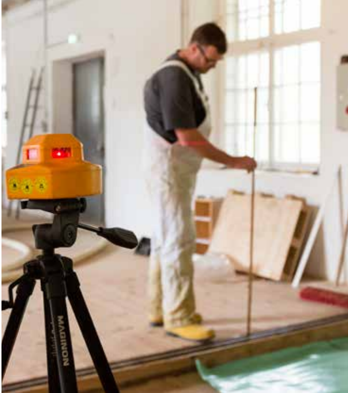
Bild 1: Lasermessungen ermöglichen genaues Arbeiten
