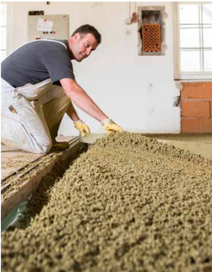
Bild 3: Vollflächiger Einbau von SikaCrete® Silent-90
