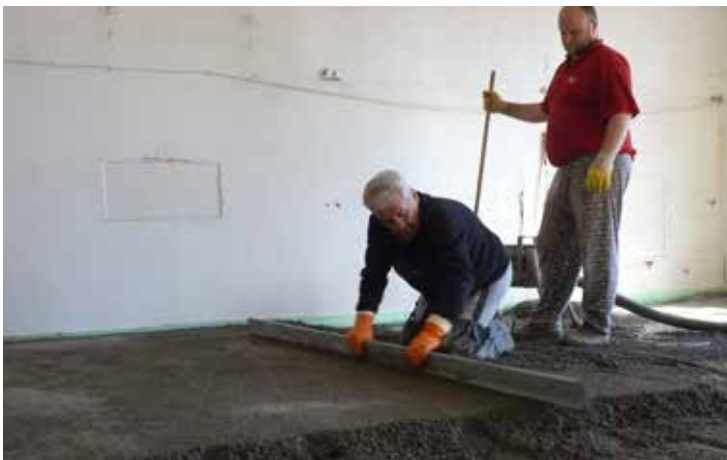
Bild 8: Einbau des hochfesten und schwundarmen Schnellestrichs
