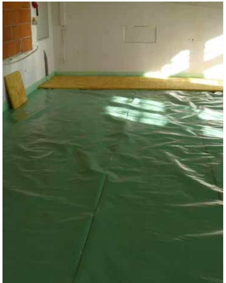
Bild 4: Sauber verlegte Dampfsperre Sarnavap® 1000 E
