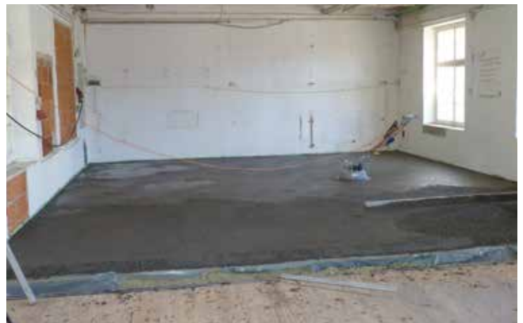
Bild 9: Der Estrich ist bereits nach 5 Stunden begehbar
