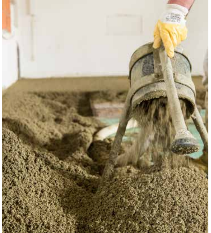
Bild 2: SikaCrete® Silent-90 wird auf die Dampfsperre aufgebracht
