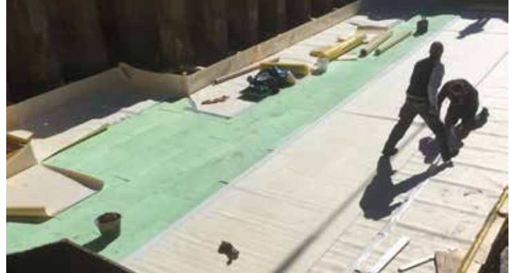
Bild 2: Horizontalabdichtung unter der Fundamentplatte durch SikaProof® A
