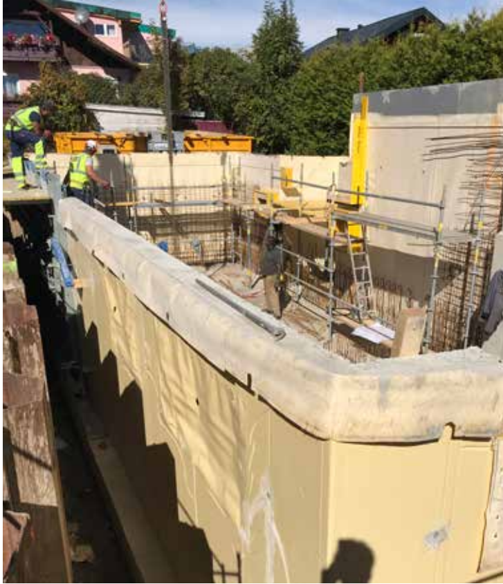
Bild 1: Dauerhafte Abdichtung der Kelleraußenwände (ca. 350 m²) durch das SikaProof® A Abdichtungssystem
