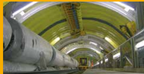
TUNNELBAU UND BAUWERKSABDICHTUNG
