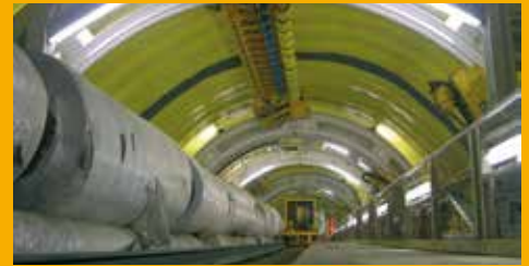
TUNNELBAU UND BAUWERKSABDICHTUNG
